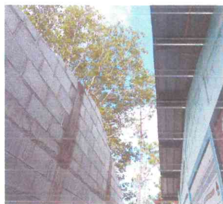
Foto 4: Pendiente de instalar el techo.
