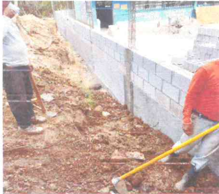
Foto 1: Estado actual del muro perimetral, malla estaba en mal estado, esta siendo sustituida en muro perimetral con malla.
